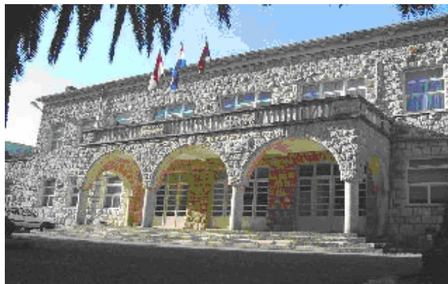
Slika 13. Zgrada Općine u Blatu
