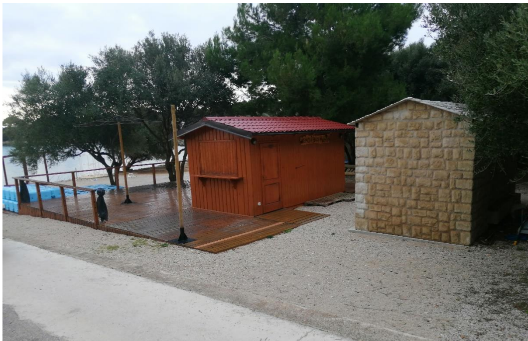
Fotodokumentacija: postojeći montažni objekti – kiosk i sanitarni čvor
